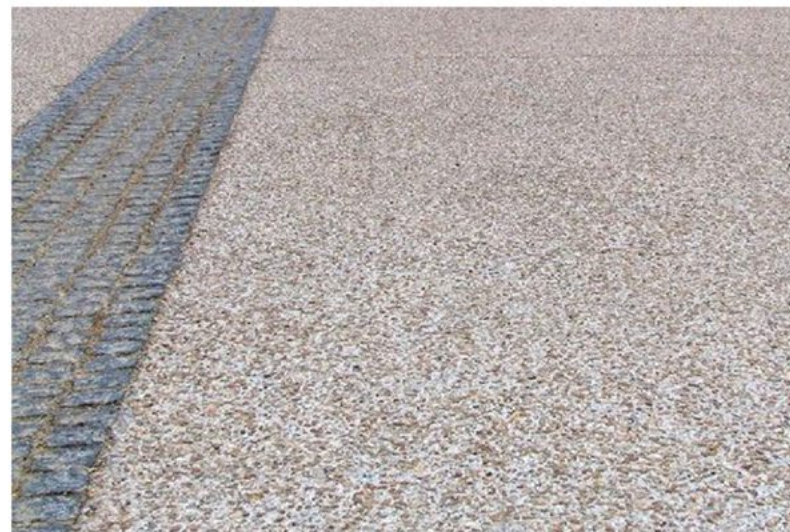
Pardoseală din beton dezactivat
